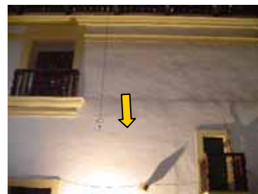
Figura 00 Prospecção por iluminação indica modificação no reboco.
